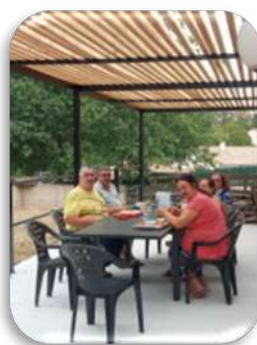
Création d'une terrasse couverte
